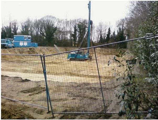
Foto door Evert Warringa van de eerste bouwwerkzaamheden.
